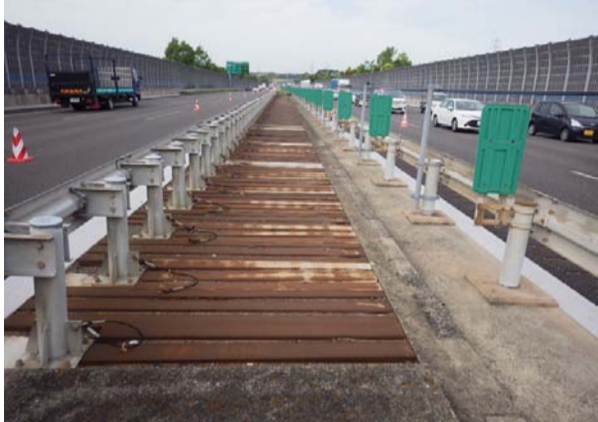
【中央分離帯 閉塞板取替え】
