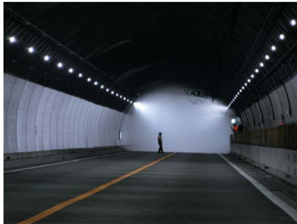
【トンネル火災に備えた水噴霧放水試験】
